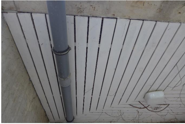
Holzpanel-Abdeckung unter Vordach Schwimmhalle (nicht im GB)
