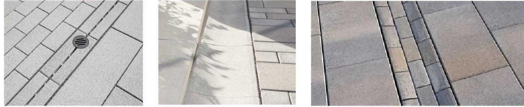
unterschiedliche Rinntypen Kastenrinne mit Steinabdeckung, Muldenrinne, Pflasterrinne
